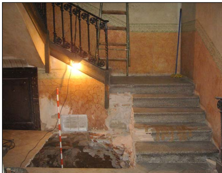
Vista general final de la cala. Els treballs arqueològics es van aturar a la cota de 1.50m, profunditat que necessitaven per encabir l'ascensor
